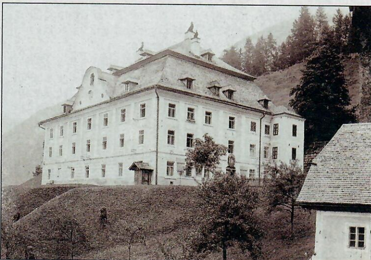
Ein Foto des ehemaligen Salzamtes aus besseren Tagen.
